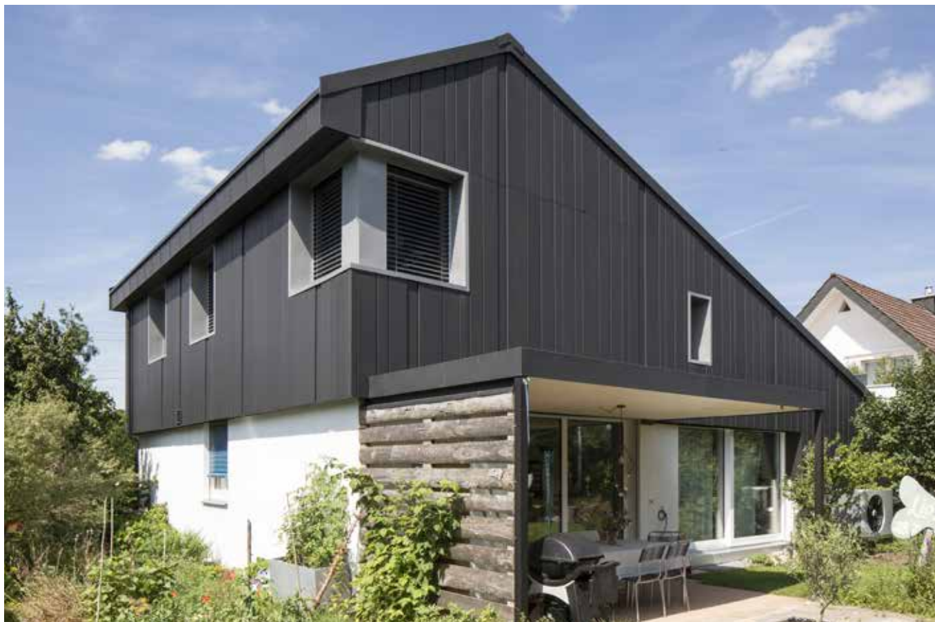
EFH Zimmermann, Rothenburg (Suisse) - Technique : Joint debout VMZINC®
