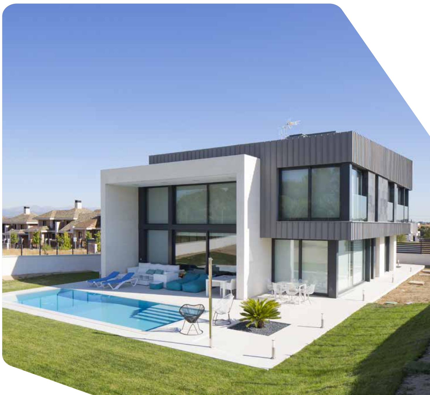
Casa unifamiliar, Majada-honda (Espagne) - Architecte : Majada-honda, Marta González - Technique : Joint debout VMZINC®
