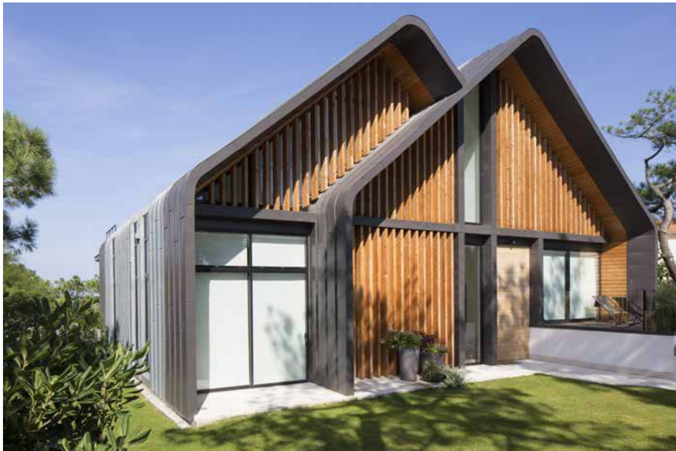
Maison individuelle Gontard, Anglet (France) - Architecte : Rebeyrol Didier, Xavier Fernandez - Technique : Joint debout VMZINC®
