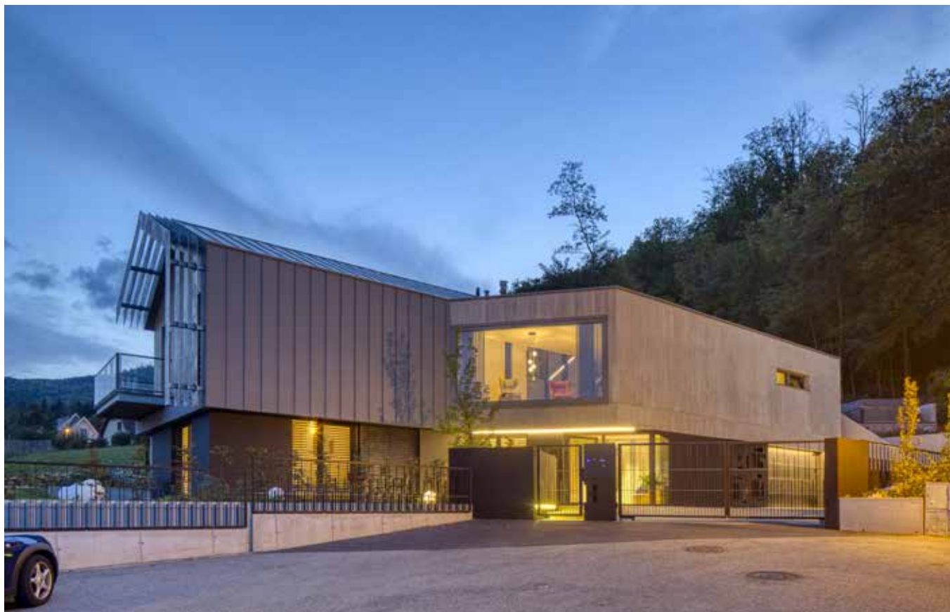
Maison individuelle Henner, Wintzfelden (France) - Architecte : KNL Architecture - Technique : Joint debout VMZINC®
