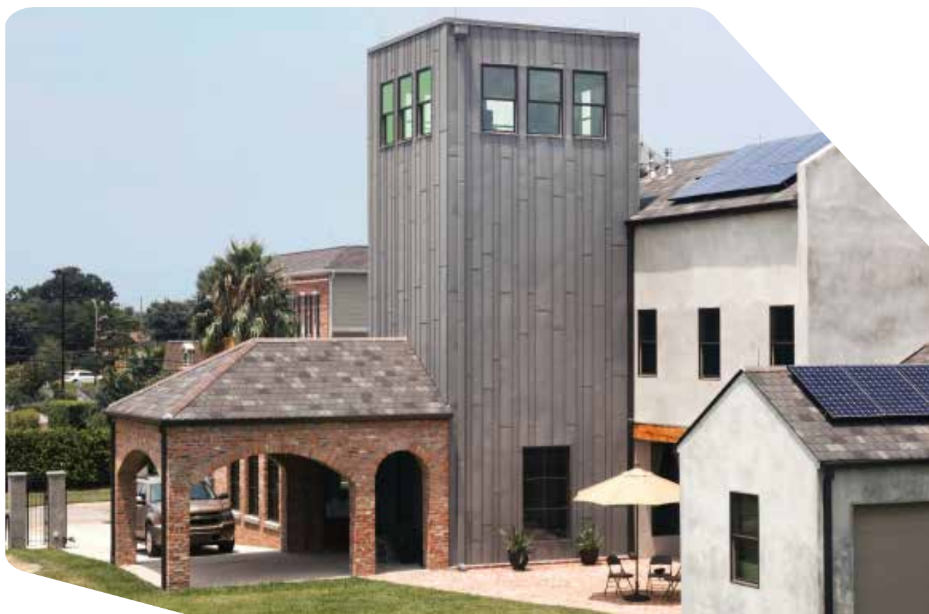
Private Residence, New Orleans (USA) - Architecte : Gwendolyn Loria - Technique : Joint debout VMZINC®
