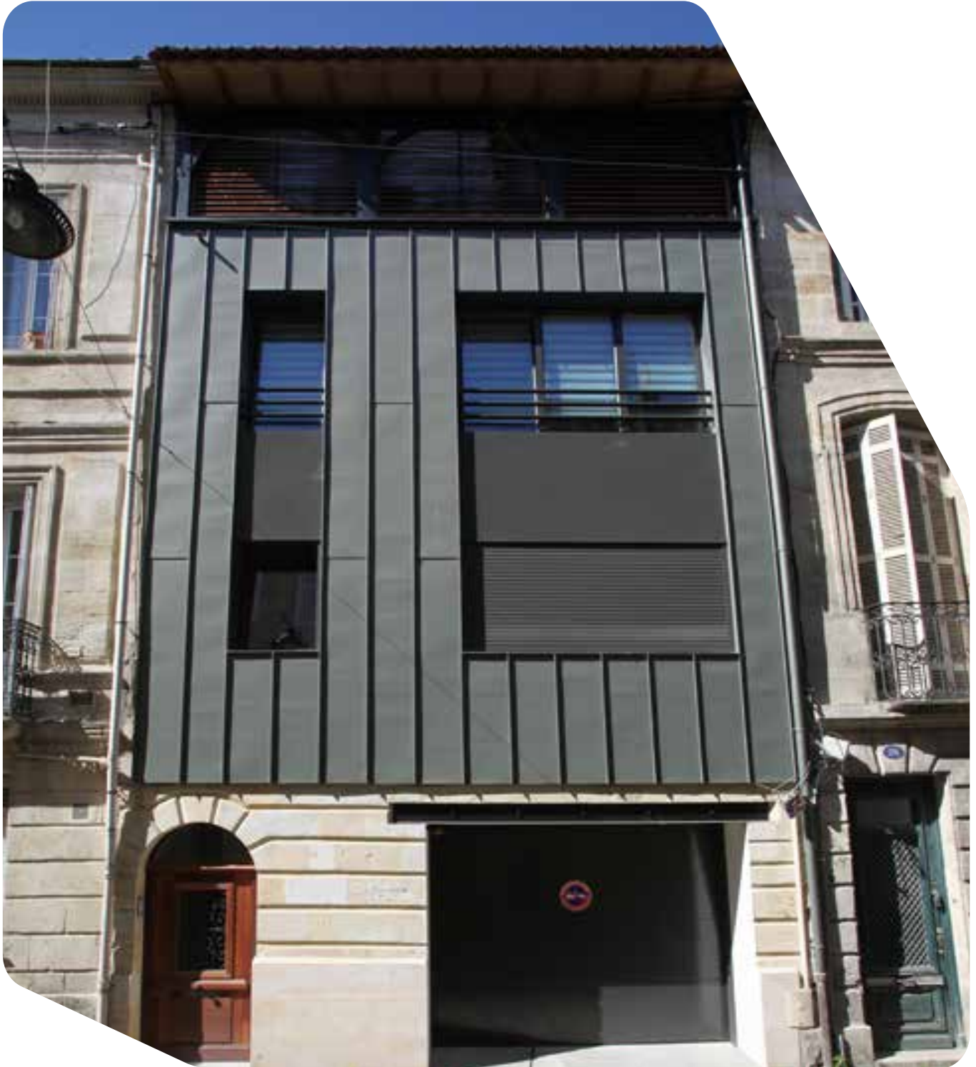
Maison individuelle, Bordeaux (France) - Architecte : Armelle Canchon Architecte, Talence - Technique : Joint debout VMZINC®
