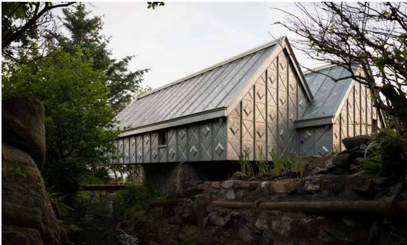
Midden studio, Ecosse (UK) - Architecte : Studio Weave.- Technique : Joint debout VMZINC®
