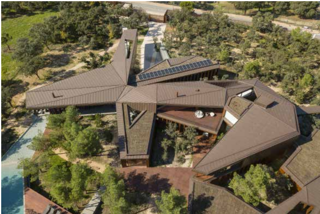
"La Moraleja" maison individuelle, Alcobendas (Espagne) - Architecte : Vasco Vieira Arquitectos - Technique : Joint debout VMZINC®
